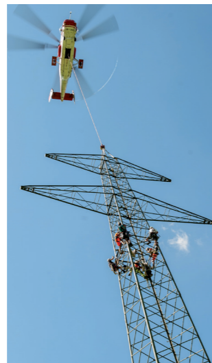
Mastmontage mit Hubschrauber
