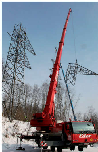
Mastmontage mit Autokran
